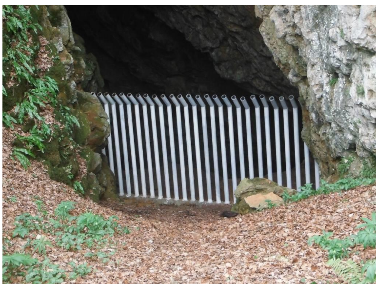
La grille de l'entrée supérieure
