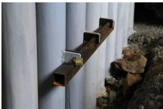
Le système de verrouillage avant et après peinture
