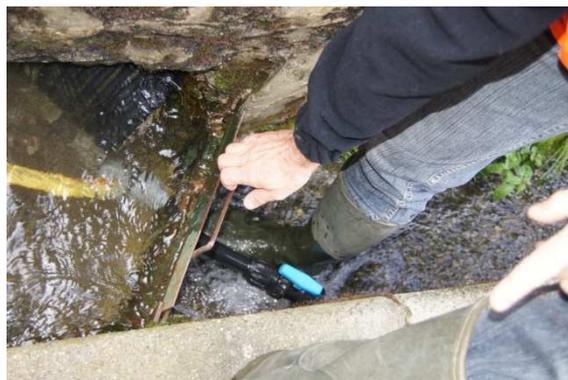
DES 026 : La canalisation passe par un jardin personnel et est munie de divers systèmes de fermeture par plaques en fer. (Photo : P. Fournier)
