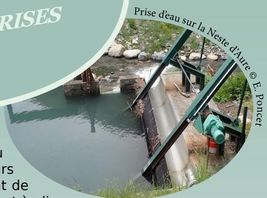
Les prises d'eau correspondent à un détournement d'une partie plus ou moins importante du débit du cours d'eau principal, au niveau d'un point de prélèvement. Elles servent notamment à alimenter des canaux d'irrigation pour l'agriculture ou des centrales hydro-électriques. Elles peuvent présenter des configurations complexes.
